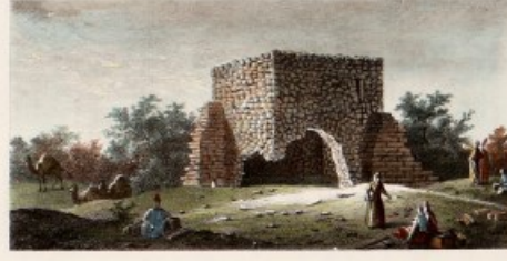
Bastion d'un Minaret en face à Paris.
