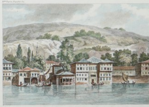
VUE DU KIOSQUE DU RESTAURANT-BAGNE A KOUROU-YOKERHES.
